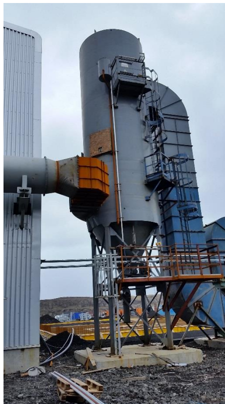
Mynd 4. Reykháfur lofthreinsivirkis á neðra svæði.
